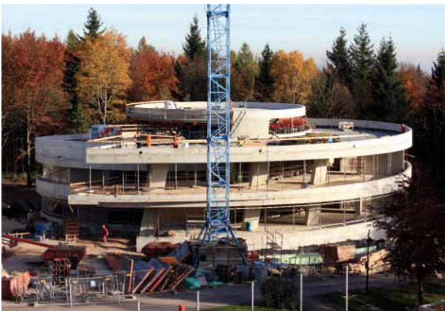
Abb. 3.6: Im Herbst 2010 kam der Rohbau des HdA zum Abschluss.
