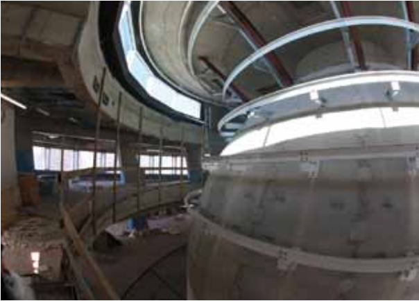
Abb. 3.7: Die Innenstruktur des HdA ist bereits klar definiert (22. März 2011).
