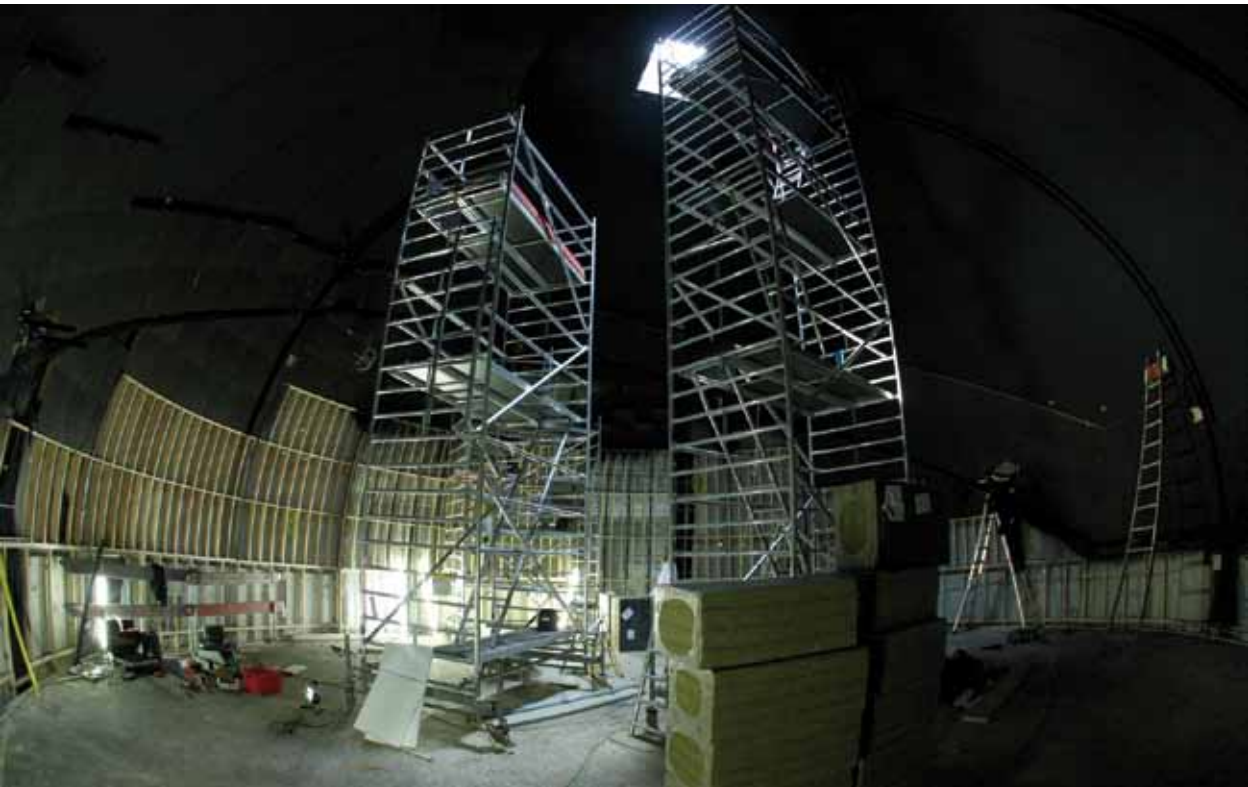
Abb. 3.8: Zur Installation der Planetariumskuppel sind im Inneren des Klaus Tschira Auditoriums Gerüste errichtet (15. April 2011).
